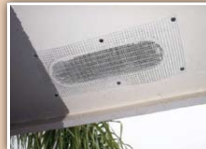
Hoyo de ventilación sellado con una malla*.
