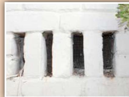
Vea que no haya mallas sueltas en los cimientos.
