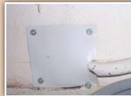
Hoyo del suministro de energía sellado con metal.*
